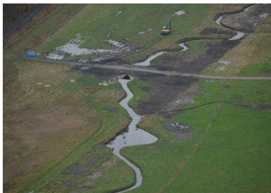
Restaurering av Fyleån
