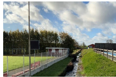
Vattnet rinner fortare i raka gjutna diken.
